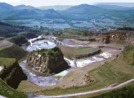
**Blick von oben auf den renaturierten Steinbruch Wolfshagen im Harz. Die ehemals ebene Steinbruchsole wurde profiliert, und es entstanden Flachwasserteiche, Blockschutthalde und eine großflächige Aufschüttung**
