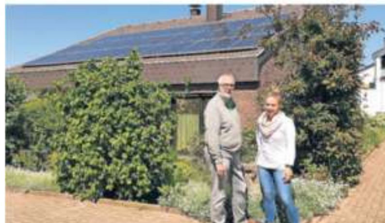
Die Ende Februar bei Hanspeter Loewen errichtete Photovoltaikanlage besteht aus 35 Solarmodulen und einem Stromspeicher mit einer nutzbaren Kapazität von 5,9 Kilowatt pro Stunde. FOTO: STADTWERKE WÜLFRATH
